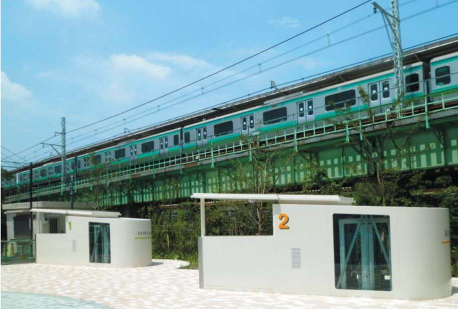
三河島駅南地区の再開発事業にて、荒川区の公共駐輪場として地下機械式駐輪場を導入。荒川・江戸川などの河川によって形成された沖積低地であるうえに、JR線に近接した場所での施工事例。周囲に影響を与えず、再開発ビル建設と調整を図りながら、省スペース・短工期施工を実現。駅の改札にも近く、利便性の高い駐輪場が完成。
