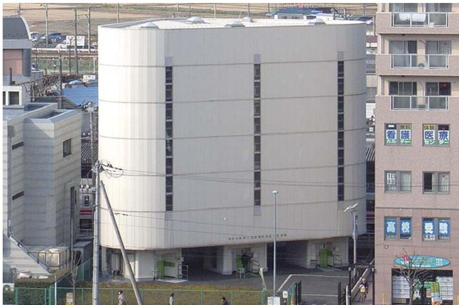
海老名駅前の相鉄線沿いにある約430㎡の限られたスペースに、地上式で720台という高収容化を実現した。4基のエコサイクルと管理室を効率良く配置し、スムーズな利用者動線を確認している。
