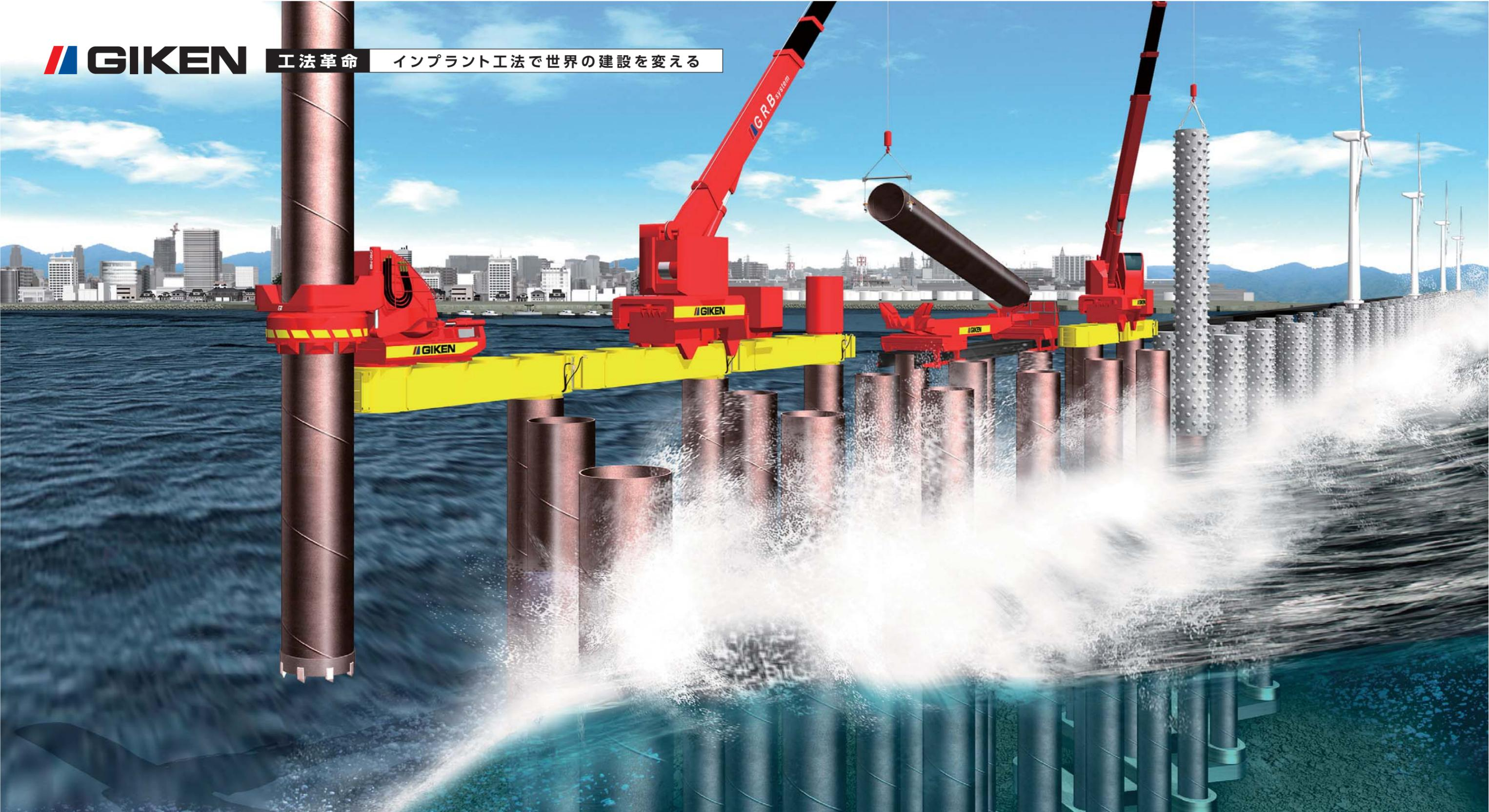
千鳥配列の強靱な杭で、津波のエネルギーを減衰・消散させる
