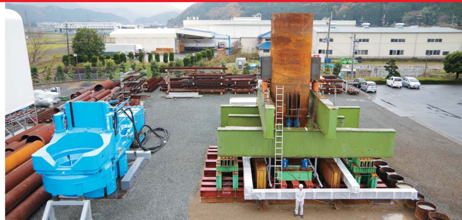
載荷試験の様子(左が大口径鋼管杭を施工したジャイロパイラー GRV2540、右が大口径鋼管杭と載荷試験装置)
