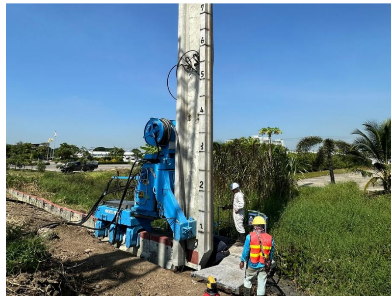
コンクリート矢板試験施工の様子
