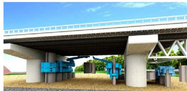
厳しい制約条件での橋脚補強技術
