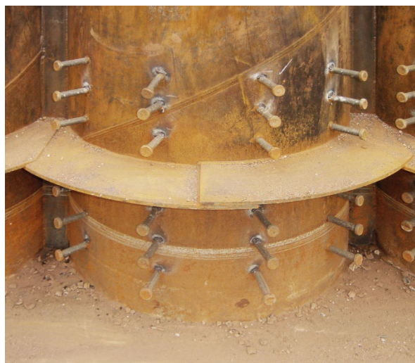
Figure 22 Slab Connection Details (Tubular Pile) – 2
