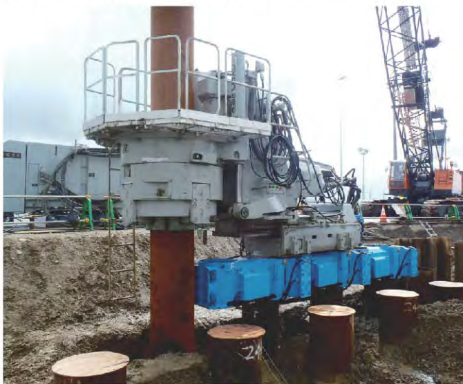
ฐานรากเสาเข็มต่อสำหรับกำแพงกันคลื่น
