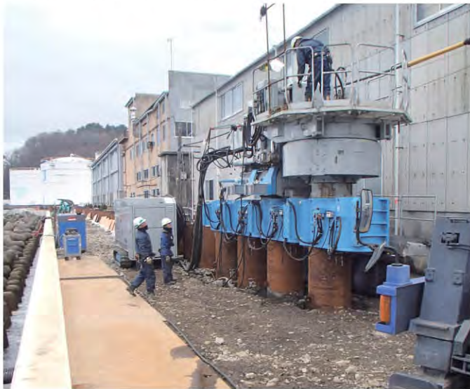
ฐานรากเสาเข็มต่อสำหรับกำแพงกันคลื่น
