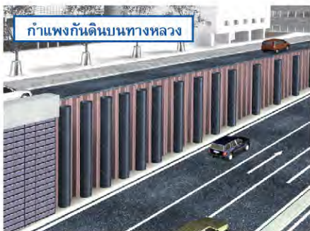
กำแพงกันดินบนทางหลวง ก่อสร้างได้ง่ายด้วยการใช้เสาเข็มหล่อสำเร็จรูป
