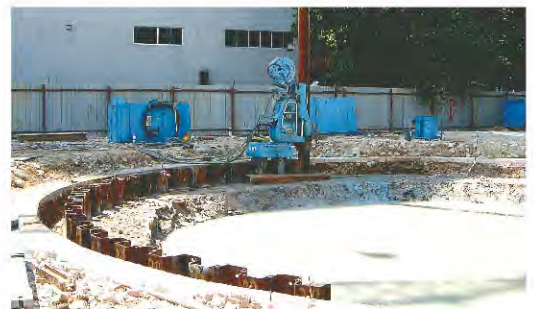
(6) เลื่อน Silent Piler ลงและใช้ขาหนีบจับกับเสาชิม
