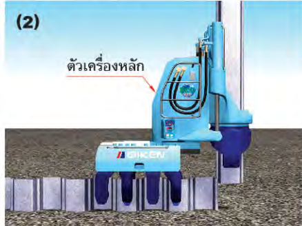
(2) ยกทอยเสาชิมแผ่นถัดไปแล้วเริ่มการติดตั้งด้วยการกด
