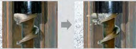
ดึงหัวสว่านขึ้นเมื่อทำการติดตั้ง Sheet Pile แผ่นนั้นเสร็จ
