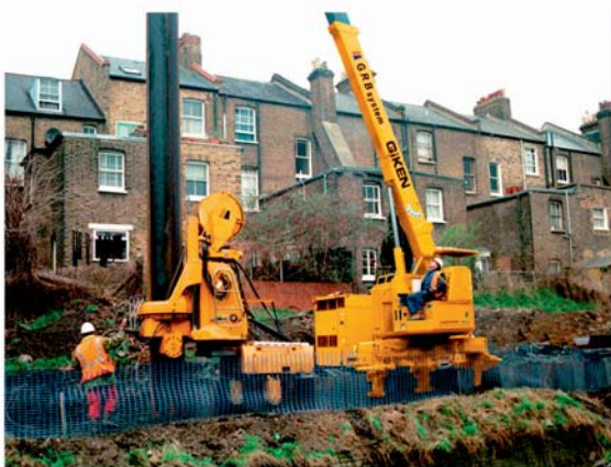
◀ 海外施工現場 (ロンドン)
