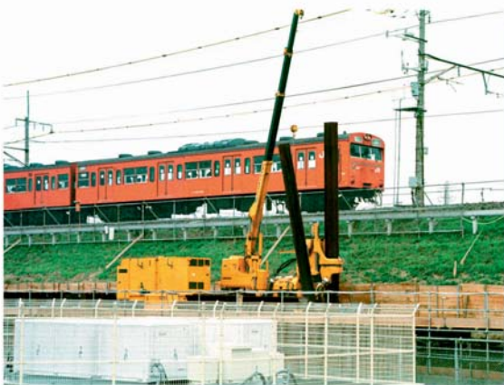
◀ GRBシステム (近接絶対安全工法)
